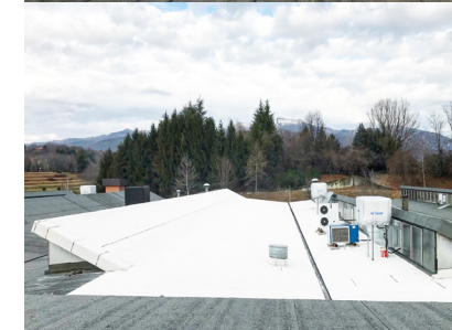
Rifacimento di una copertura industriale con membrana bituminosa Firestoop ardesiata bianca, indicata dove si trovano pannelli fotovoltaici
