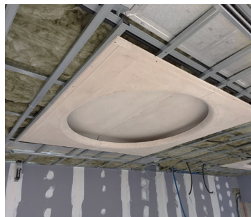
Hotel, Como - Coibentazione e decoro di un soffitto
