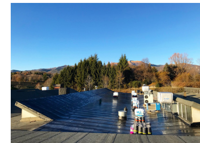
Rifacimento di una copertura industriale con membrana bituminosa Firestoop ardesiata bianca, indicata dove si trovano pannelli fotovoltaici
